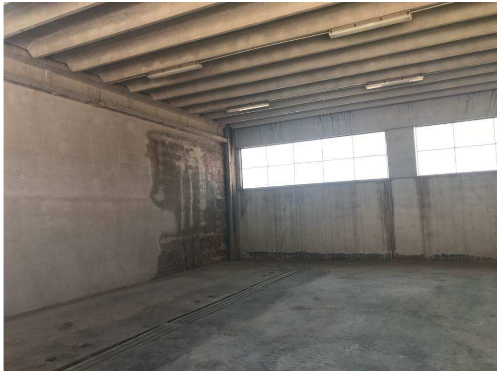
foto 16 capannone destinato a laboratorio animali infetti - interni
