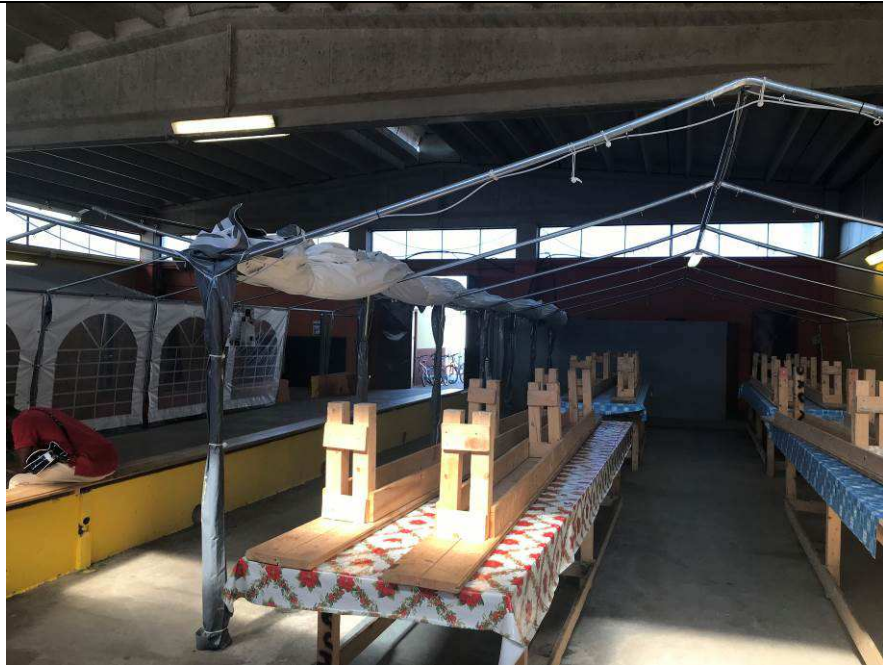
foto 19 capannone destinato a stalle, depositi mangimi, stanza stalliere - stalle
