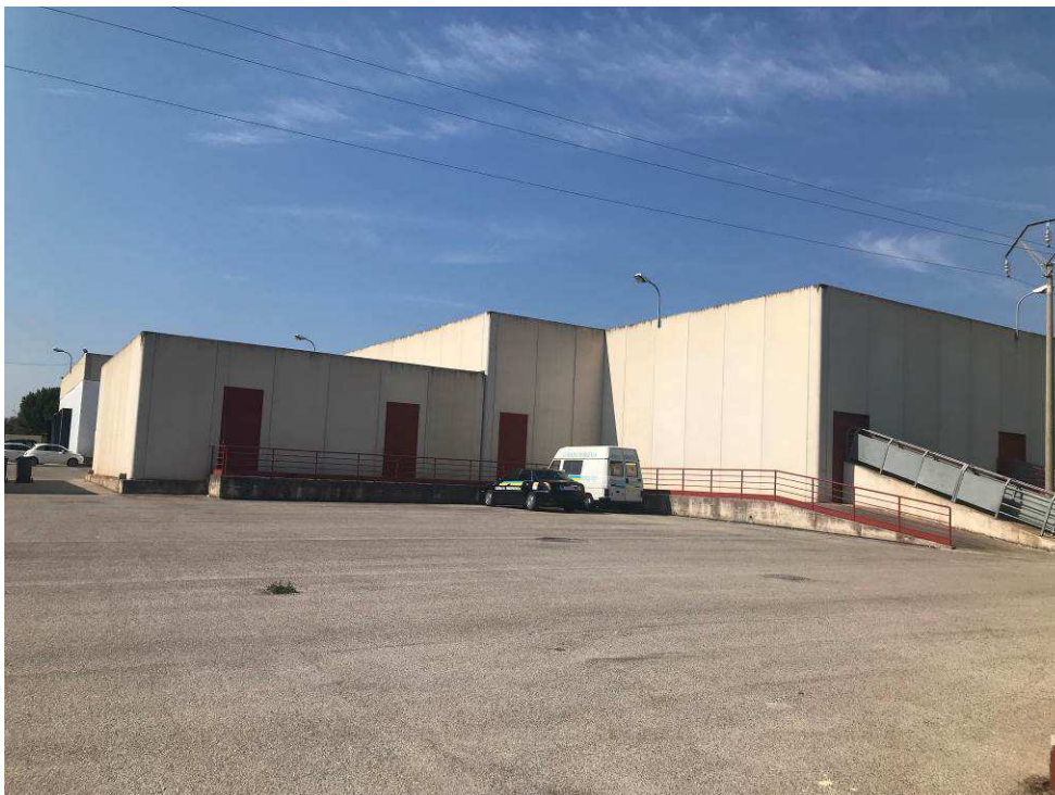
foto 4 capannone destinato a mattatoio – prospetto laterale
