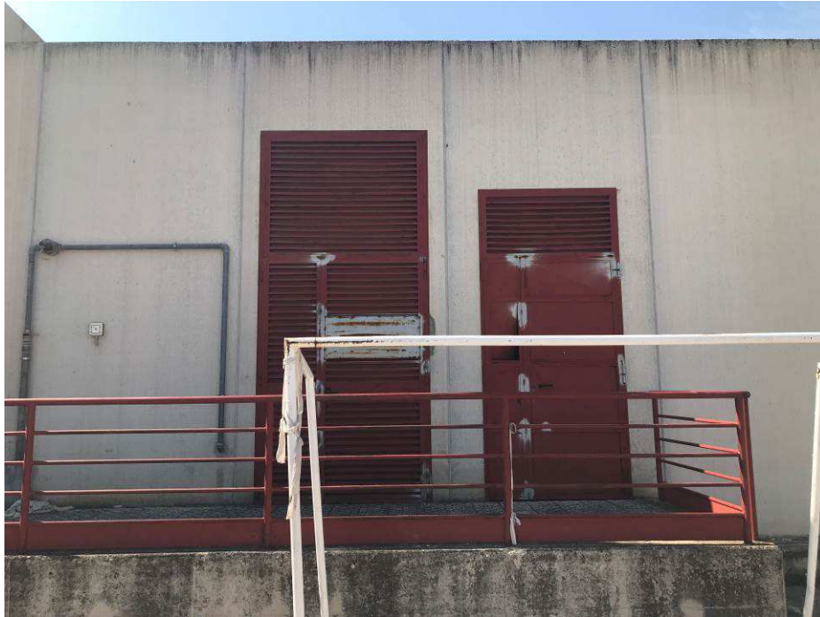
foto 11 capannone destinato a mattatoio – locali tecnologici
