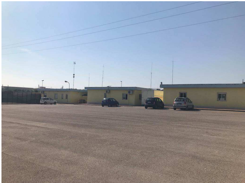
foto 22 retro palazzine ufficio
