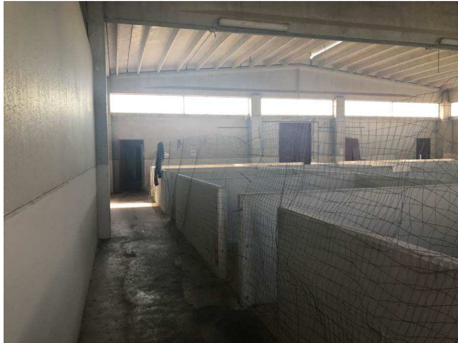
foto 18 capannone destinato a stalle, depositi mangimi, stanza stalliere - stalle
